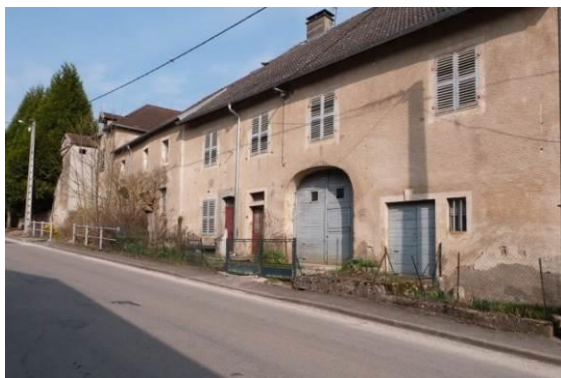
Figure 267 : Ferme monobloc à Ferrières-les-Scey.
