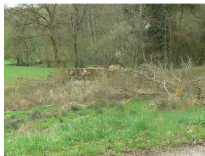
Figure 246 : Infrastructure ancienne (pont en pierres)
