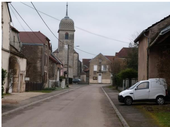
Figure 263 : Eglise de Chantes.
