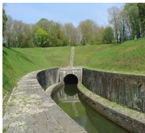
Figure 117 : Tunnel du canal de Saint-Albin.
