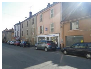
Figure 77 : Vue générale (avec vacance).
