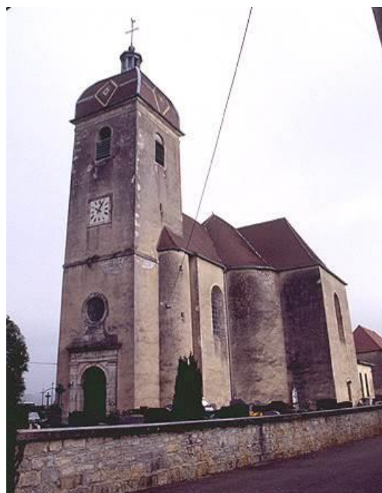
Figure 266 : Eglise de Traves.
