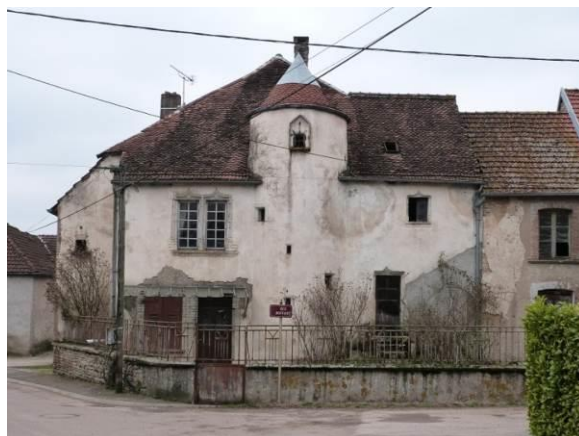
Figure 276 : Maison d'habitation à Ovanches.
