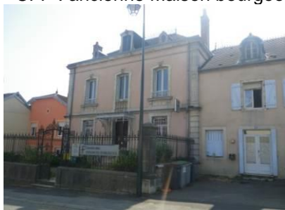
Figure 131 : Centre des Finances Publiques de Scey-sur-Saône et Saint-Albin.
