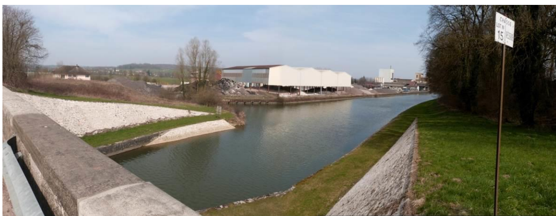
Figure 67 : Vue générale depuis la RD3 (pont du canal).
