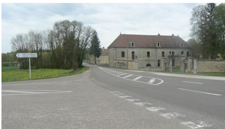
Figure 238 : Entrée du territoire par le RD3 et l'ancienne Abbaye.
