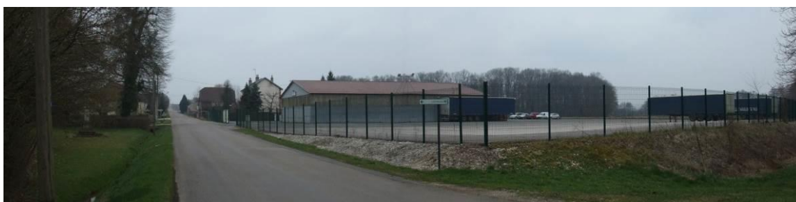
Figure 73 : Accès à l'entreprise depuis la RD3 (limite Nord de l'emprise).
