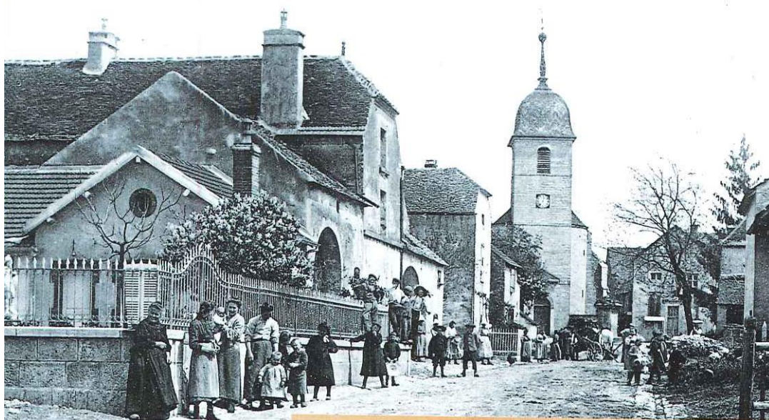
OVANCHES - Rue de l'Église
