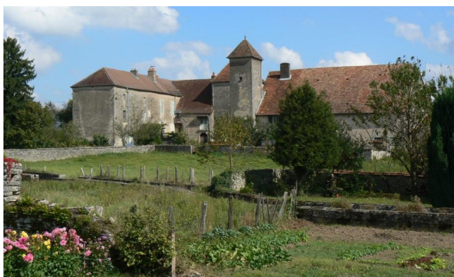
Maison forte de Ferrières-les-Scey.
