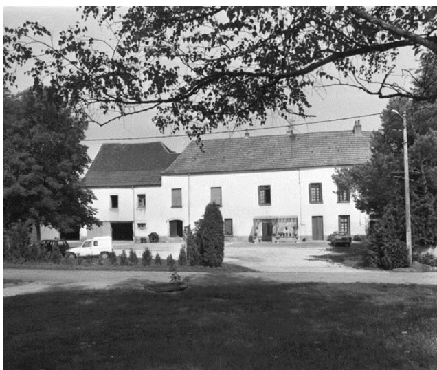
Ancien atelier de fabrication
