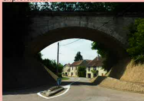
Photo n° 9 : passage sous voie ferrée à Raze
